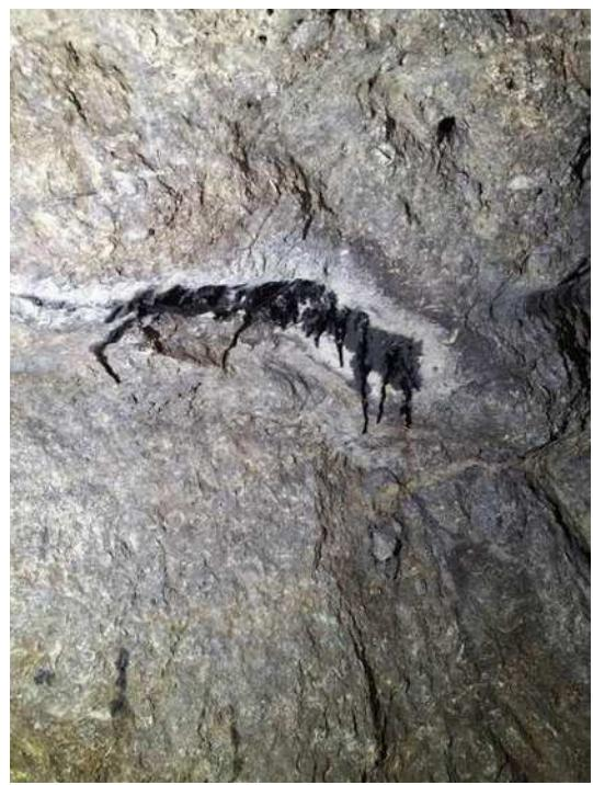
Par endroit l'asphalte coule de micro fissure...
